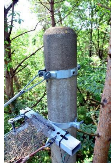
西側支柱上部
