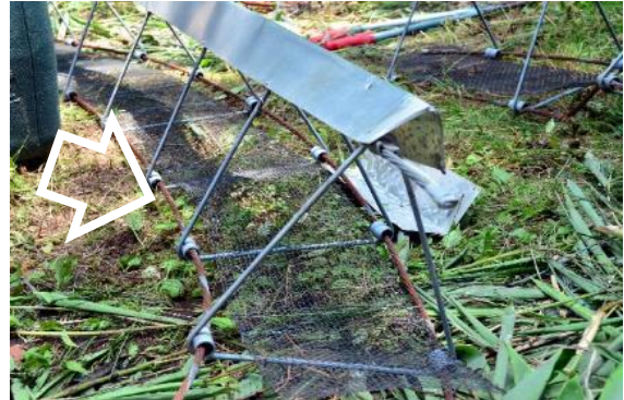
下部の錆びたワイヤーとフレームの状況
