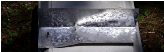
アルミの屋根（上：外側、下：内側）
