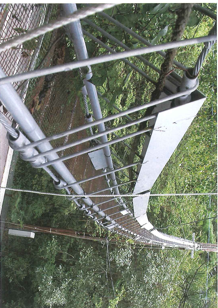
断面がトライアングル形状の吊り橋構造が特徴のアニマルパスウェイ Animal pathway suspension bridge with the distinctive triangular cross section.
