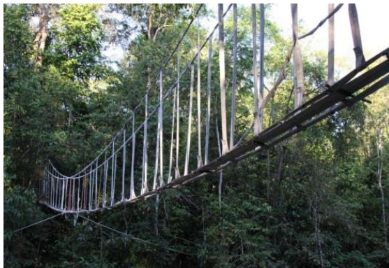
消防ホースを再利用した吊り橋
