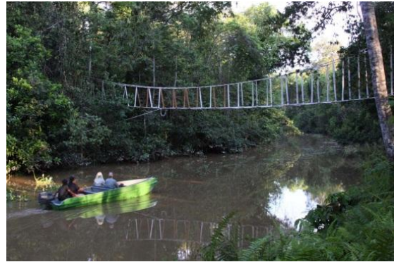
川の上に造られた吊り橋
