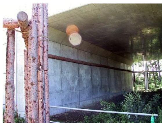
道路下のカルバート
